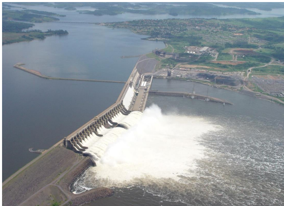
Figura 3. Vista da Usina Hidrelétrica de Tucuruí mostrando parte do reservatório durante o período de cheia. Fonte: Cintra (2009).
