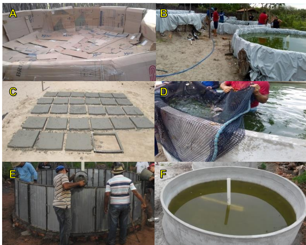
Figura 1. Etapas de construção tanques em sistema de recirculação d'água A e B, com piscina adaptada à aquicultura sobre placas de concreto; C e D em molde de concreto E e F.
