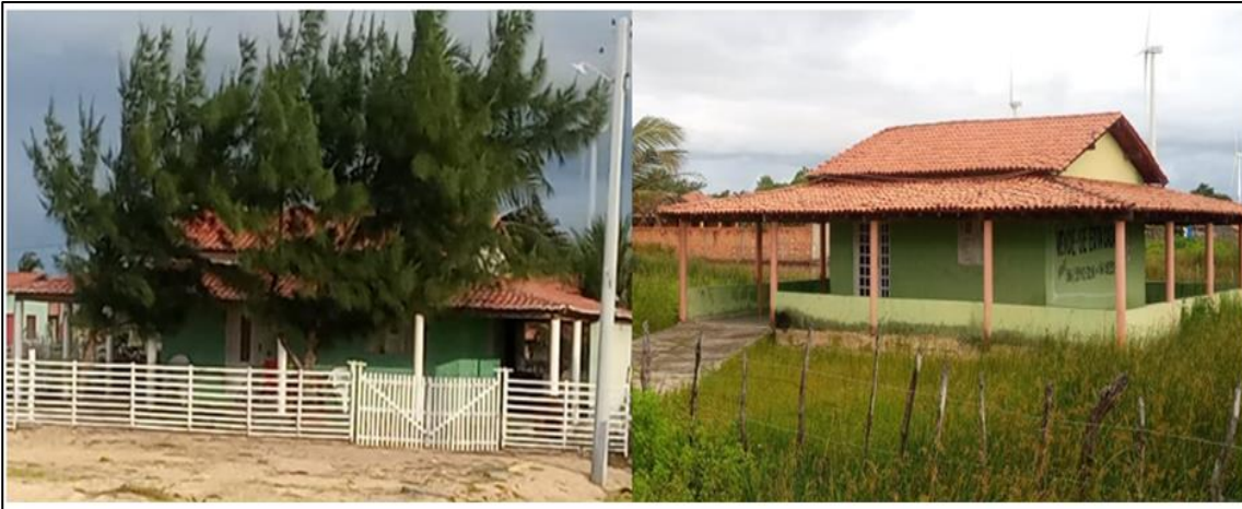
Figura 2: Segunda residência na Praia Pedra do Sal – Parnaíba/PI.
